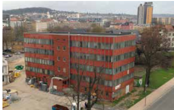
Die einstige Schaltzentrale eines Großbetriebes: Die „Tomate“, kurz vor ihrem Abriß 2013
