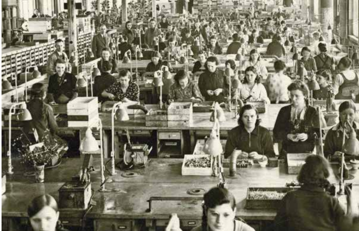
Blick in einen der Montagesäle (1943)
